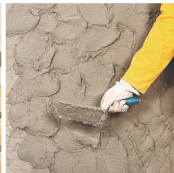
Obr.2b Nebo omítání zdiva.
