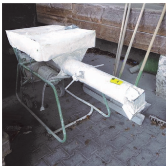
Obr.1a Namíchání malty pomocí kontinuální míchačky.
