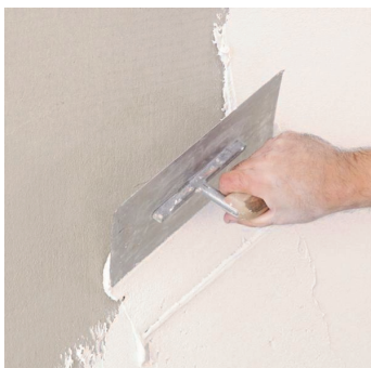
Obr. 2 Nanášení omítky pomocí nerezového hladítka.
