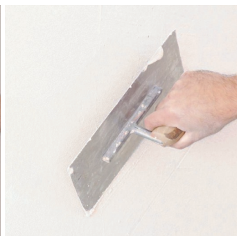
Obr. 3 Urovnání povrchu.
