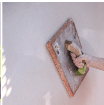
Obr.4 Navlhčení povrchu a vyhlazení houbovým hladítkem, možno i různými hrubostmi.
