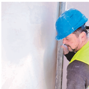
Obr.3 Po zatuhnutí stržení povrchu "v-latí" a zatlačení zrn do omítky fasádní špachtlí.
