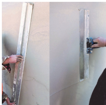
Obr.2 Urovnání povrchu "h-latí" a fasádní špachtlí.
