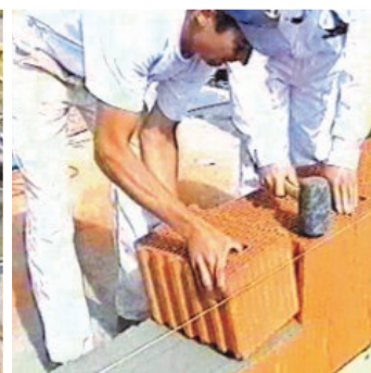
Obr.3 Pokládání cihelných bloků.
