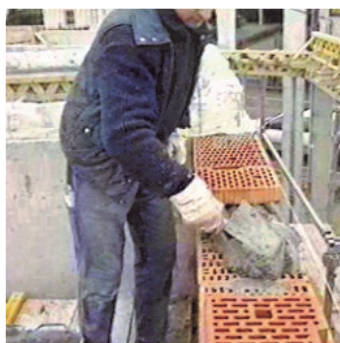
Obr.2 Nanášení zdicí malty na zdivo.
